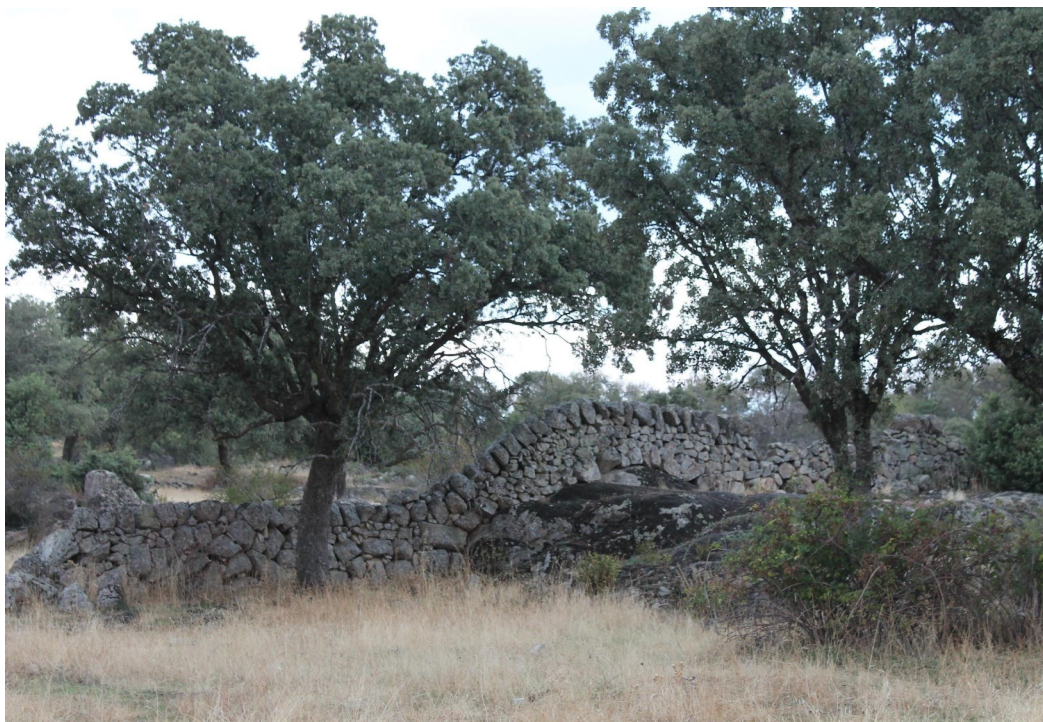
Figura1: Muro en Prado del Buche directamente sobre afloramiento. Fuente: Fotografía del autor.
