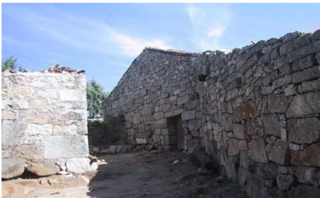
Figura 10: El conjunto de la Figura 9 antes de su demolición. Fuente: Antonio Tenorio para la Asociación Cultural El Ponderal..
