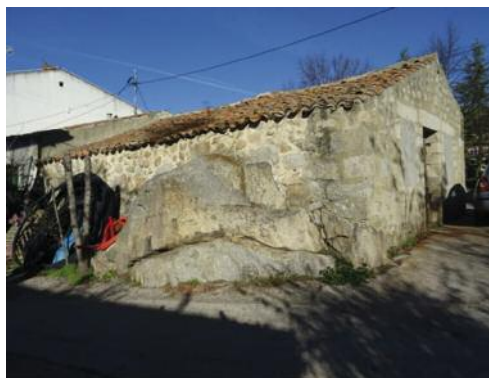
Antiguo pajar en la calle Erillas 19, Hoyo de Manzanares, derribado en 2017
